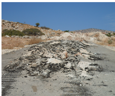
Demolerad väg i Al Aqaba
